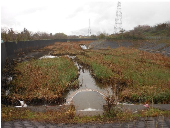
↑) 4/9 朝の状況, オイルフェンスとマットが設置されている。オイルフェンス付近に油膜が目視できた。
