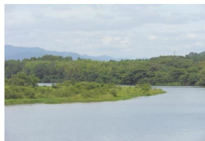
海倉にせり出した堆積洲 右岸側は大変浅くなっている
