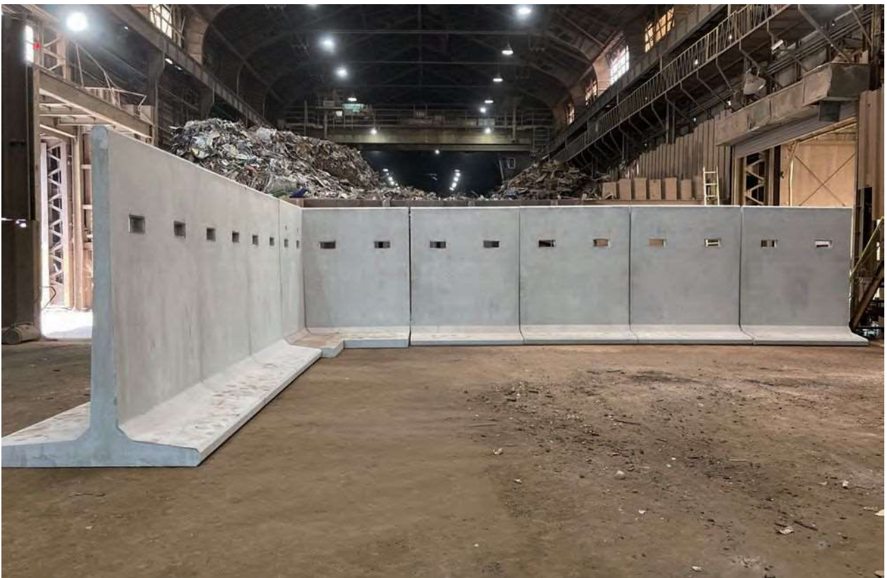
コーナー部材を活用した資源物リサイクル施設内の分別ヤード
