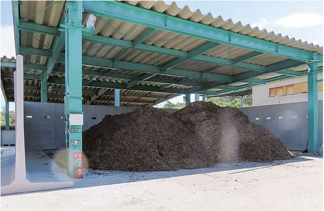
コーナー部材を活用した木材チップ保管施設
